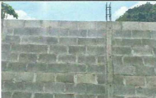
Foto 5: Pared existente externa
