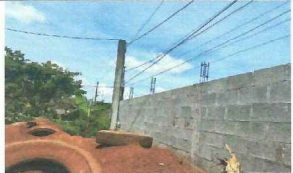
Foto 2: parte lateral derecho de la cocina.
