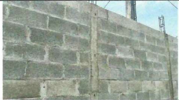
Foto 6: Pared externa existente
