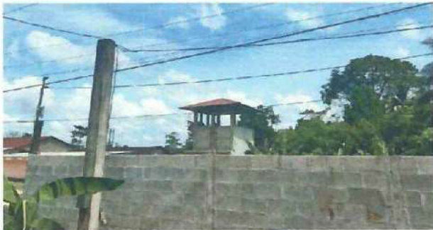
Foto 3: Pared existente de la cocina.
